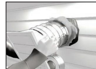
**2** Faites passer le conduit flexible isolé dans l'ouverture jusqu'à ce qu'il soit bien tendu et droit. Faites glisser le manchon en vinyle interne du conduit sur le collet avec l'isolation et placez le parevapeur sur le manchon. Fixez à l'aide de ruban adhésif en toile.
